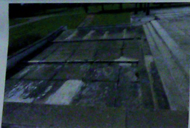
NIWELACJA POSADZKI DO RZEDNEJ - 0,95 podsypkę piaskową gr 3 cm dla ułożenia płyt tarasowych np. Tonino kolor caldo 29,6X29,6 cm, firmy Libet
